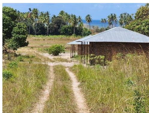
Foto 4 - Habitações junto á estrada de acesso do Projecto
